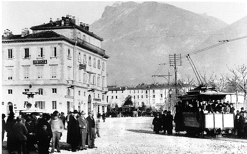
Brown Boveri suchte kurz nach der Firmengründung nach Lösungen für Fahrstromsysteme mit höheren Spannungen und konnte 1896 die Drehstromstrassenbahn in Lugano dem Betrieb übergeben. Deutlich erkennbar ist die problematische, aber systembedingte Doppelführung des Fahrleitungsdrahtes. Glasplatte Brown Boveri. Repro Slg. N. Lang, Baden.
