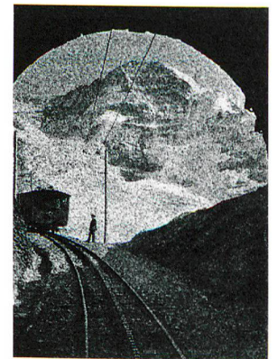
6 Jungfraubahn, elektrisch betriebene Zahnradbahn.
