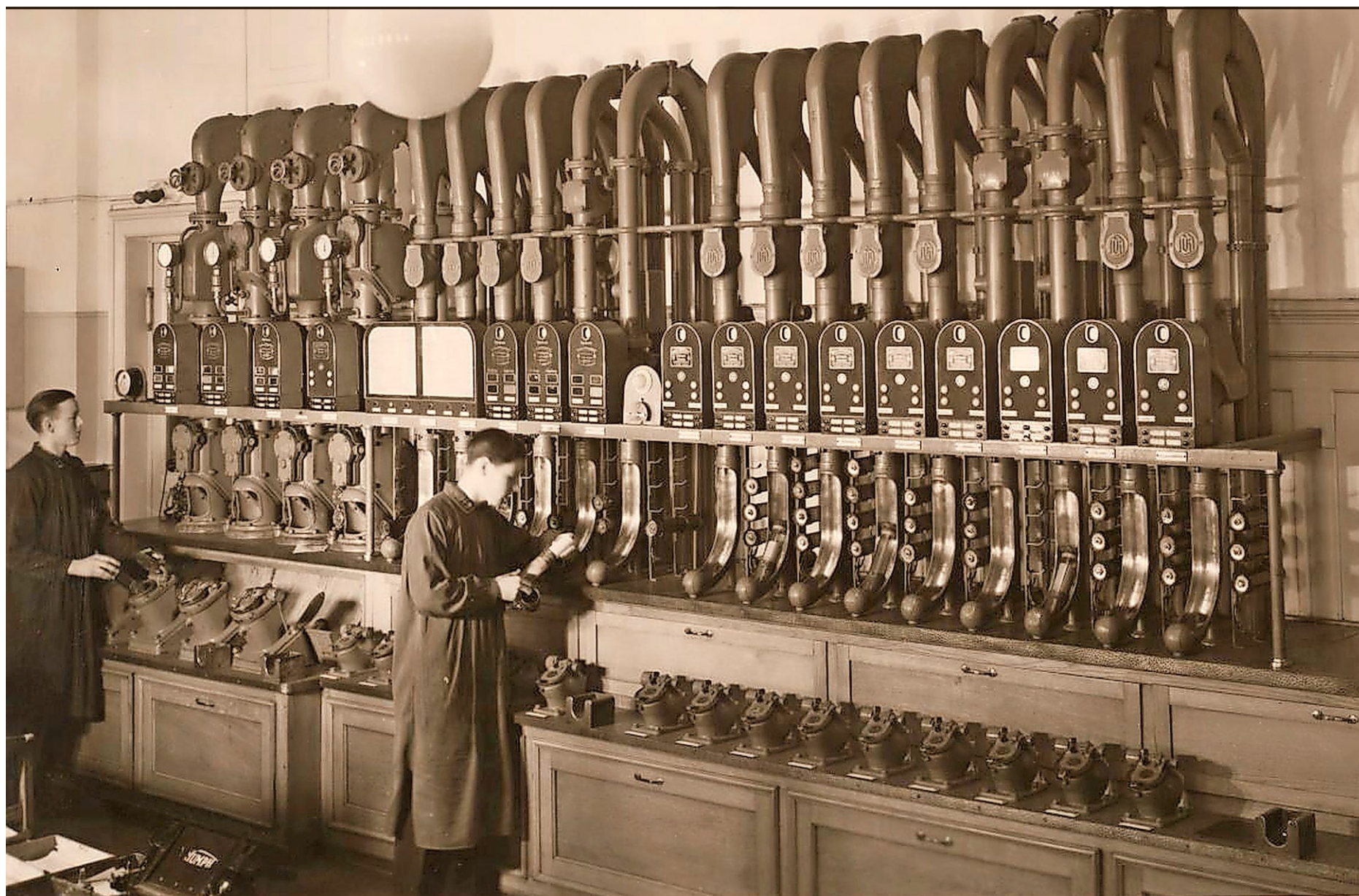
Die Rohrpostzentrale im Telegrafenamnt Zürich um 1930. Eine Rohrpostbüchse schaffte im Durchschnitt 12 Meter pro Sekunde. Foto: Hans Meiner (Museum für Kommunikation)
